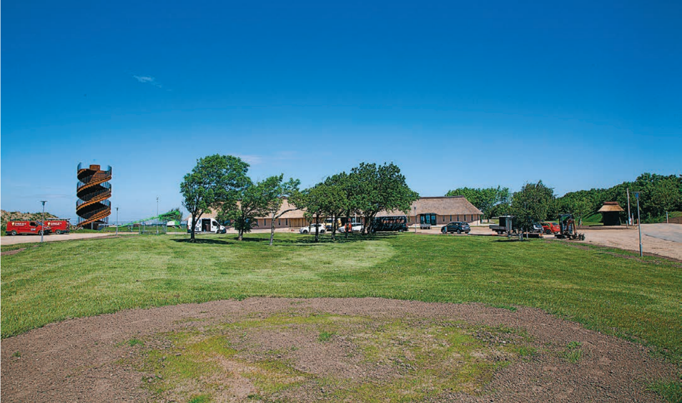
Der Turm aus Cortenstahl wird noch wachsen.
