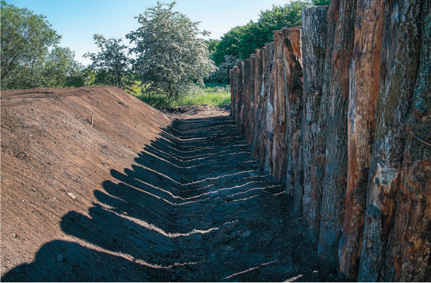
Die Eichenstämme wurden nicht so tief in den Boden gerammt, wie es die Angeler vor 2.000 Jahren noch machen mussten. Damit morsche Pfähle später ausgewechselt werden können, wurde ein Fundament mit Beschlägen in das Erdreich gegossen.
