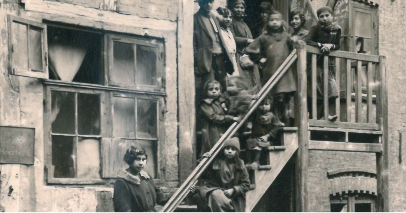
Die Sinti-Familie Weiß lebte in einem baufälligen Hinterhaus in der Norderstraße, ehe sie zwangsweise in eine Baracke am Stadtrand umgesiedelt und später nach Polen deportiert wurde. MUSEUMSBERG FLENSBURG
