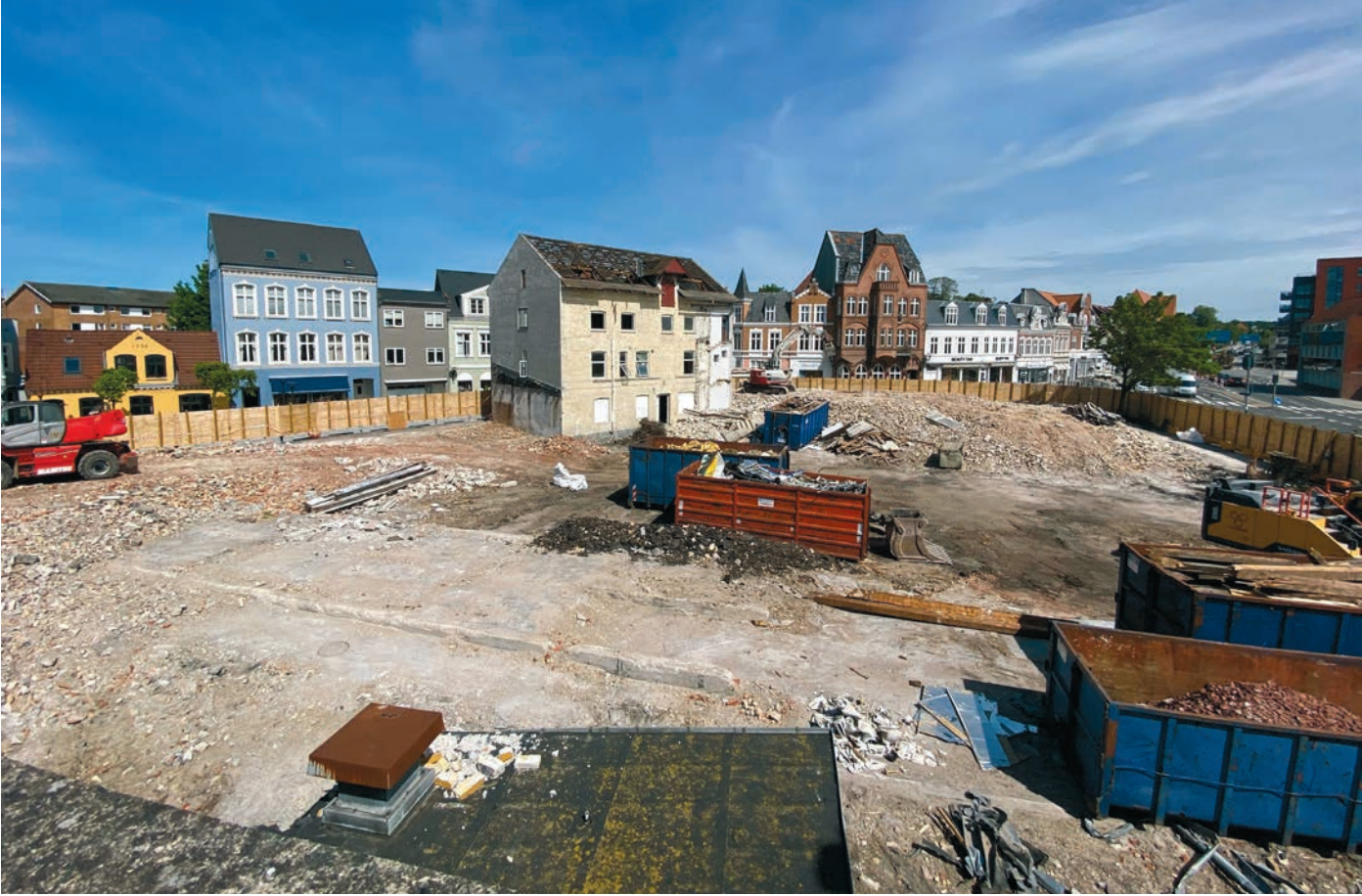
Blick über den Bauplatz: Der Schutthaufen rechts war einmal das „Hotel Danmark“. Auf dem Gelände am Nordertor (Nørreport) stehen noch zwei Gebäude, die auf den Abriss warten.
