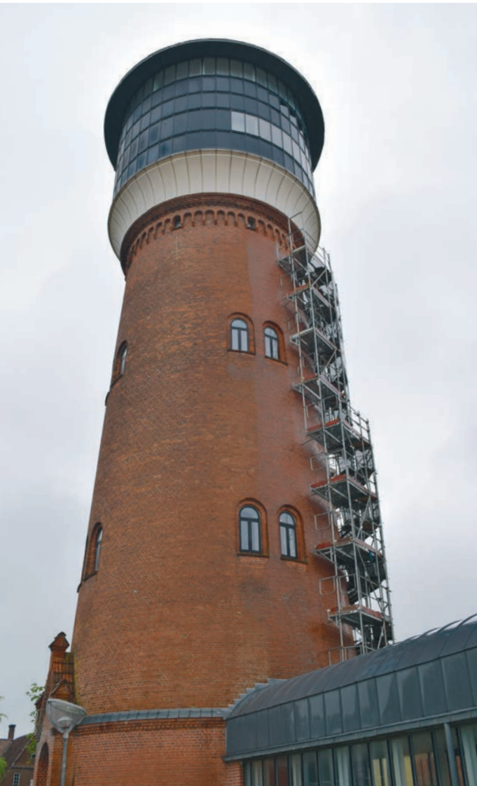
Das Baugerüst verhalf den Stuhldieben zum Aufstieg. An Höhenangst können die Einbrecher nicht gelitten haben. FOTO: B. LASSEN
