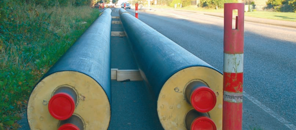
Möglicherweise werden auch in Tingleff bald Fernwärmerohre verlegt. KJELD THOMSEN
