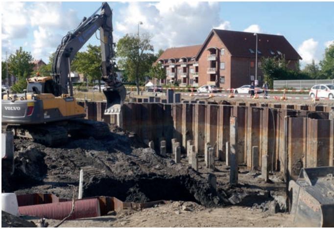
Die zum Bau des neuen Schöpf- und Sperrwerkes an der Mühlenaumündung erforderlichen Spundwände sind alle in den Untergrund gerammt worden. Jetzt beginnt bald das Schütten der Betonkonstruktion, in der ab Ende 2023 die Pumpen bereitstehen, die Apenrade trotz des absehbaren Meeresspiegelanstiegs vor „nassen Füßen“ bewahren sollen. VOLKER HEESCH
