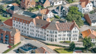
Das weiße Gebäude am Gravensteiner Hafen wird innen komplett umgebaut. FOTO: FREJA EJENDOMME
