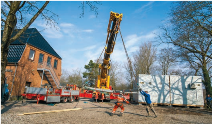
Für das Aufstellen der Wohncontainer wurde auf einen großen Kran zurückgegriffen. FOTO: KARIN RIGGELSEN
