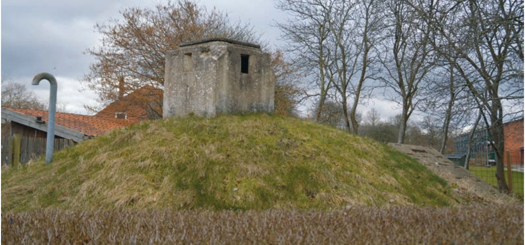
Bei gezielter Suche stößt man in der Carstensstraße auf einen der vier Luftschutzräume in Tondern. FOTO: MONIKA THOMSEN
