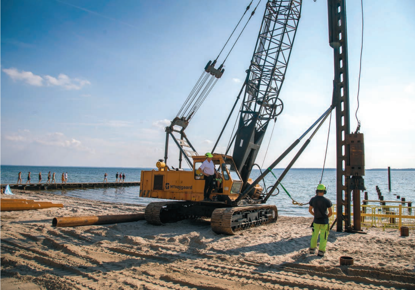
Erik Lauritzen auf dem Telekran beim Einhämmern des ersten Eisenpfahls
