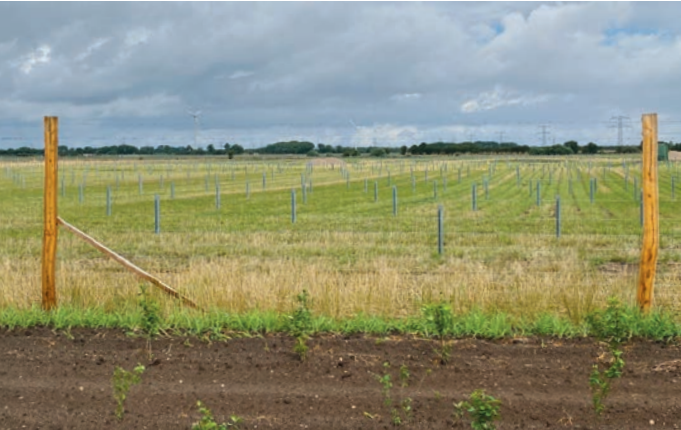
Die Basiselemente, auf denen die Solarzellen noch befestigt werden, stehen bereits großflächig. Hier ist ein Teil der Anlage bei Julderup zu sehen.
