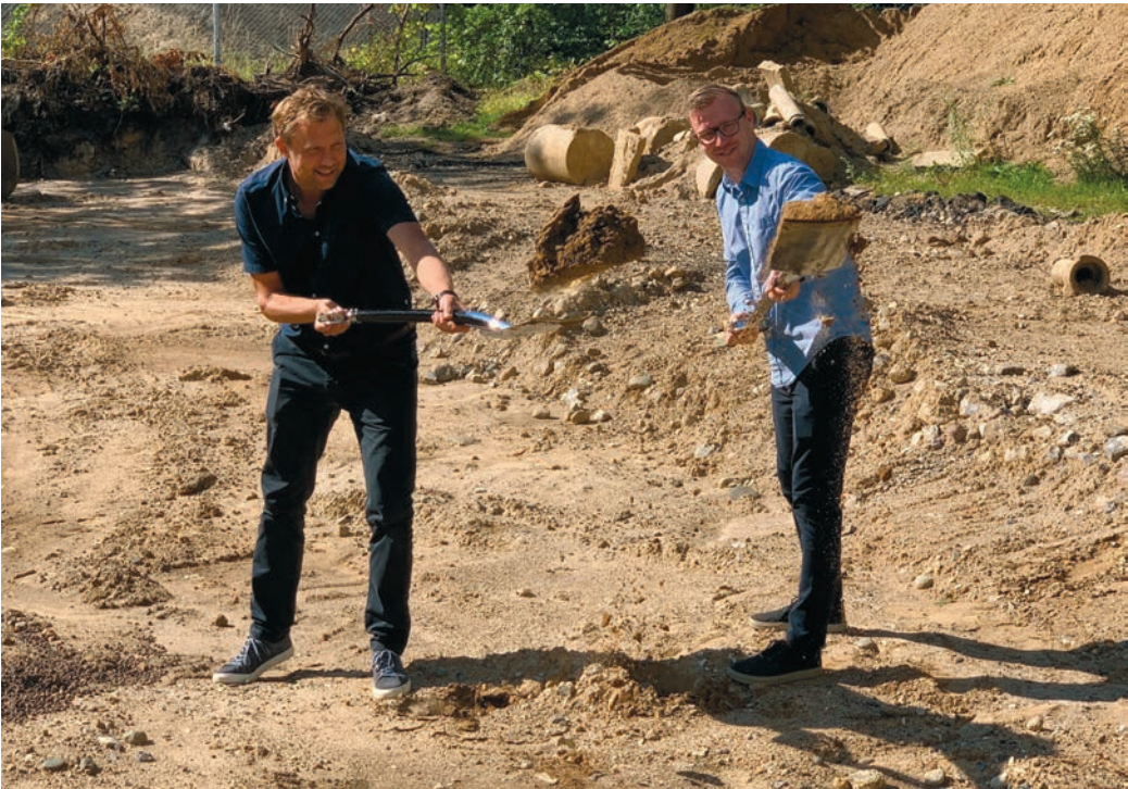
Stephan Kleinschmidt (l.) und Jesper Kock beim ersten Spatenstich FOTO: ILSE MARIE JACOBSEN
