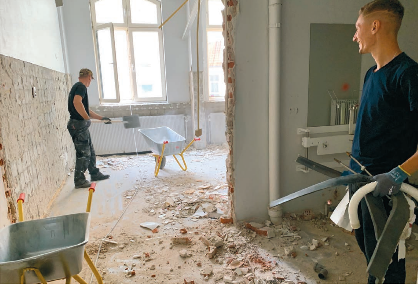
Überall wird schwer gearbeitet. Doch es gibt noch viel zu tun.
