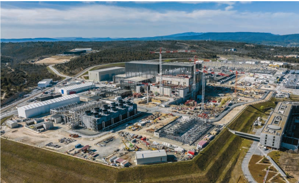
Die Baustelle von oben
