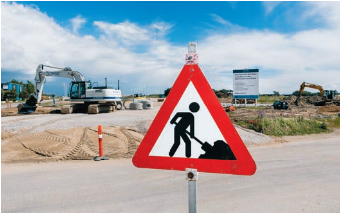
Bagger stehen auf einer Baustelle für den geplanten Fehmarnbelt-Tunnel.
