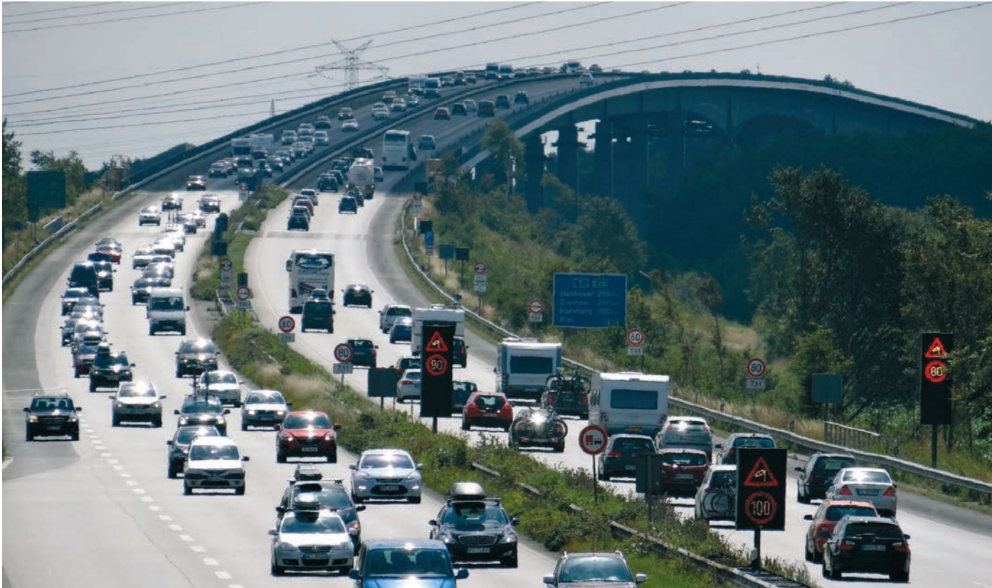
Reiseverkehr rollt auf der A7 über die Rader Hochbrücke.
