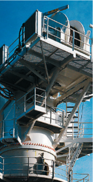
Große Trägerkonstruktionen aus Stahl entstehen in Rothenkrug. VALMONT SM
