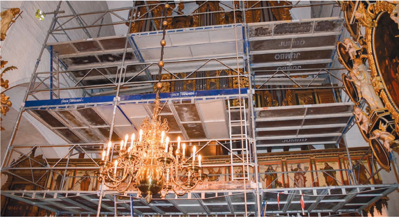
Ein großes Baugerüst ist vor der Orgel der Christkirche aufgebaut worden.
