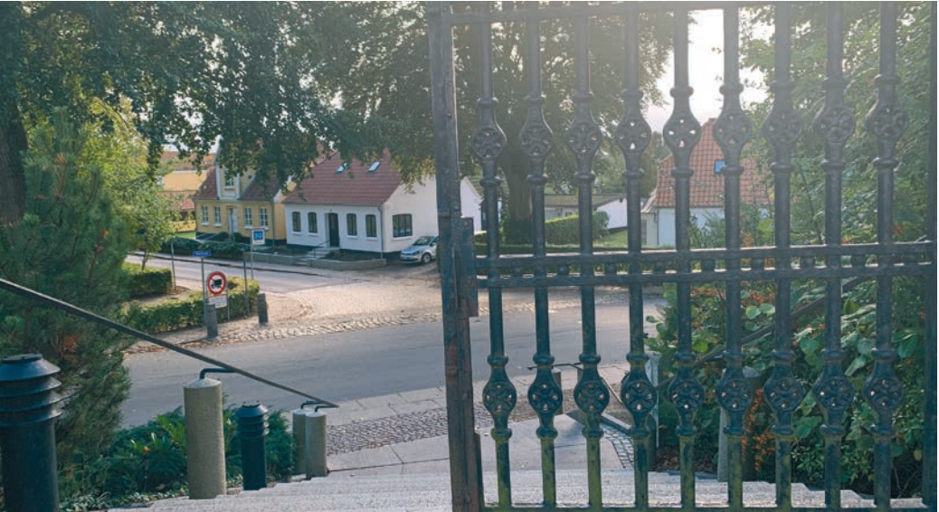
Das neu renovierte Haus aus Sicht der Treppe vor der Kirche im Jahr 2022
