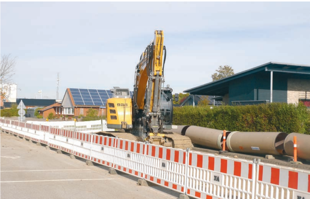
Im Bereich des Straßenzuges Åbjerg in Krusau sind bereits Fernwärmerohre zur Versorgung von Neukunden der Pattburger Fernwärmegesellschaft verlegt worden. In diesem Bereich der Ortschaft wird parallel eine neue Regenwasserkanalisation verlegt.
