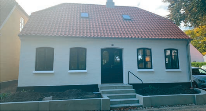
Das Haus hat ein neues Dach erhalten, der Schornstein ist wieder aufgebaut worden, und statt geputzt ist die Fassade freigelegt und mit Kalkmörtel bekleidet.
