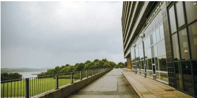
Für die künftige Nutzung des früheren Krankenhauskomplexes muss ein neuer Flächennutzungsplan erarbeitet werden.
