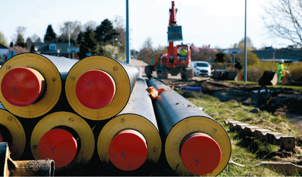
Fernwärmerohre werden voraussichtlich auch auf Südalßen verlegt, sodass 2024 die Wärme durch die Leitungen fließt. FINN FRANDSEN/RITZAU SCANPIX
