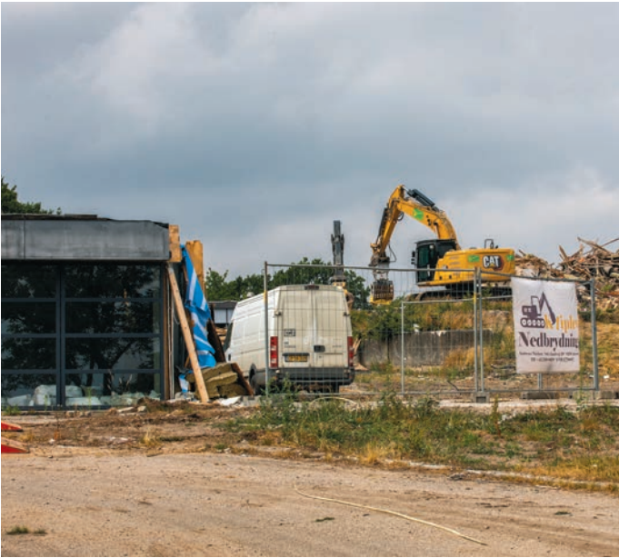
Das Abrissunternehmen „Klipleff Nedbrydning“ ist mit ihren Maschinen vor Ort.
