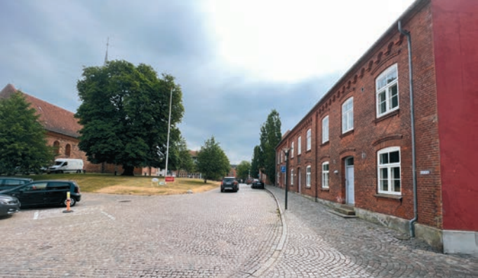
Im rechten Bildabschnitt ist das Gebäude, in dem die „schrägen Wohnungen“ Platz finden sollen. Im linken Bildhintergrund liegt die Nicolaikirche. JAN PETERS
