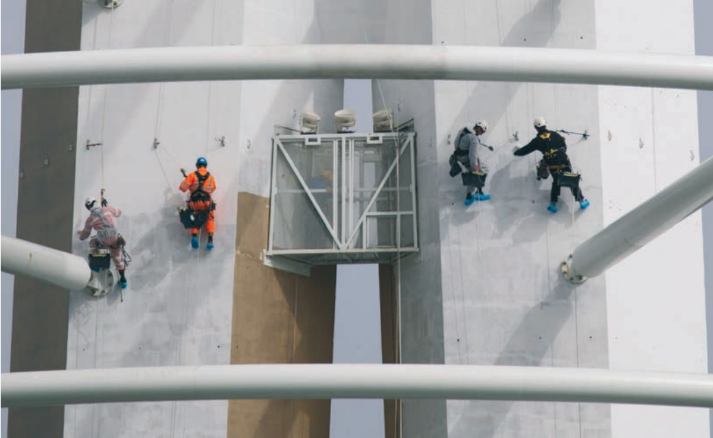
Spezialisten klettern an der Außenseite des „Spinnaker Towers“ und streichen dabei den Aussichtsturm im Hafen von Portsmouth.
