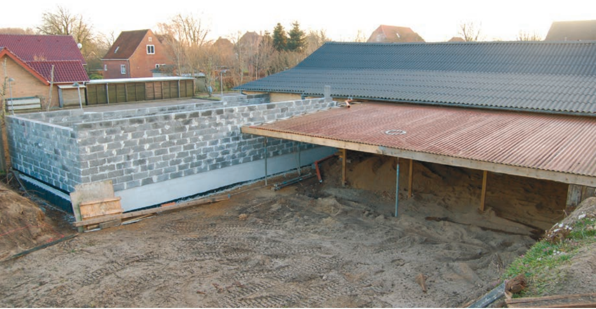
Der neuen Luftgewehrbahn fehlt noch das Dach.
