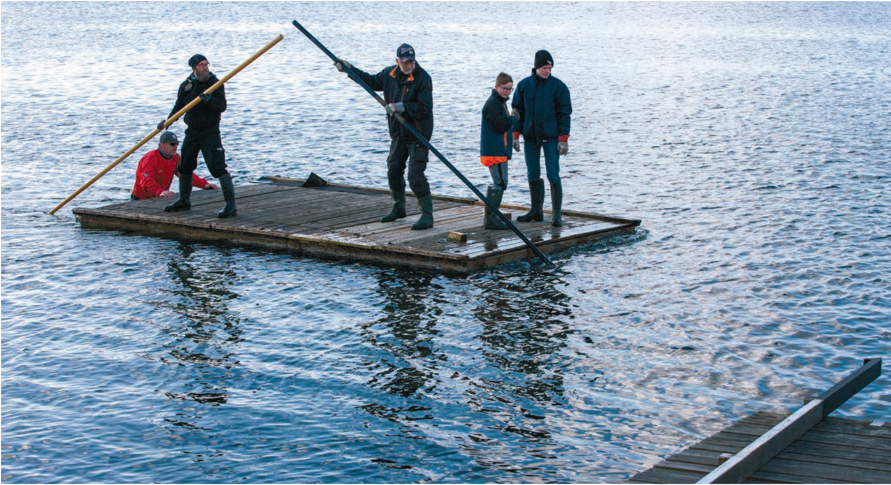
Schwimmend und mit vereinten Kräften wie ein Floß kommt die Brücke an die richtige Stelle. FOTO: KARIN RIGGELSEN
