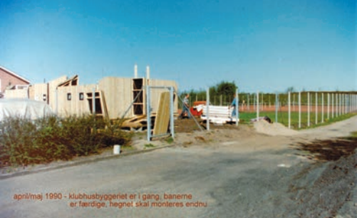
Bau der neuen Anlage neben der Schwimmhalle
