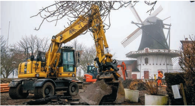
Gegraben wird zurzeit auch bei der Mühle in Hoyer. FOTO: ULRIK PEDERSEN (TØNDERMARSK INITIATIVET)
