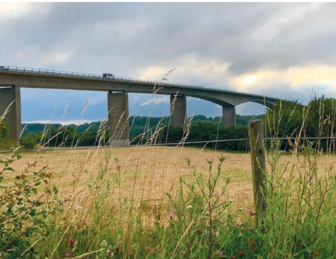
Die Alsensundbrücke von 1981 ILSE MARIE JACOBSEN
