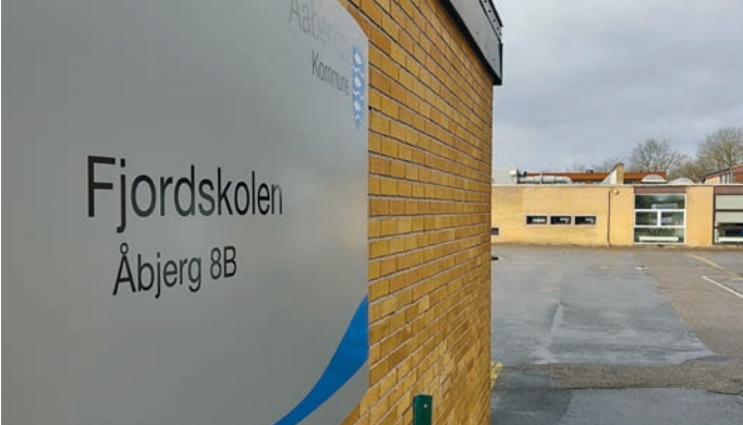
Der „Fjordskole“ am Åbjerg in Krusau steht eine umfangreiche Sanierung bevor.
