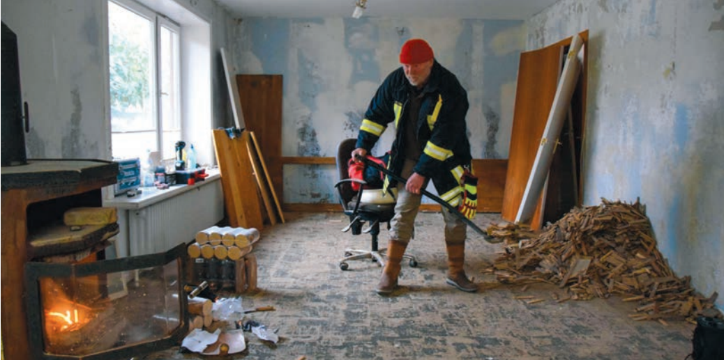
Der Ofen ist zurzeit die einzige Wärmequelle im Haus von Ralf Timm im Arnisser Lindenweg. Weil das Wasser auch sein Feuerholz weggeschwemmt hat, verheizt er inzwischen sein ohnehin zerstörtes Stäbchenparkett. REBECCA NORDMANN/SHZ.DE
