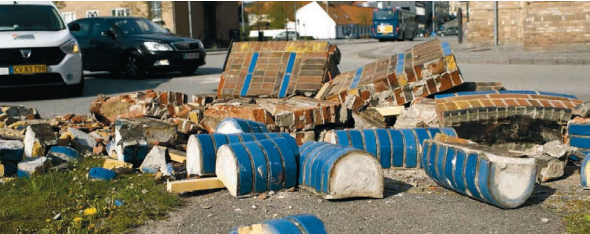
Ein Teil der Mauerbrocken war auf der Straße gelandet.
