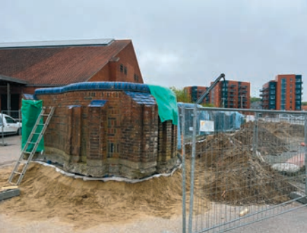
Der größte Teil der Telemauer steht seit Mittwoch an seinem Platz.
