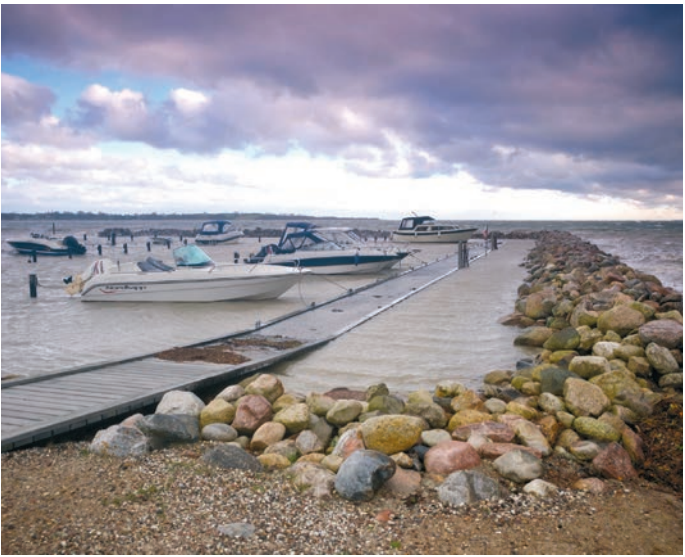
Der Jollenhafen beim Hochwasser im November 2022
