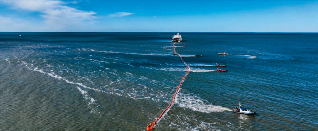
Die Rohre des Viking Links erreichen durch das Wasser das Festland.
