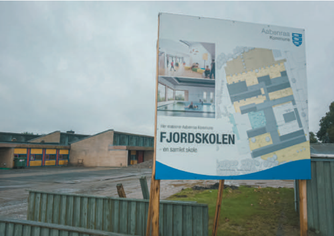
Nach dem Umbau der ehemaligen Kommunalschule in Krusau zur „Fjordskole“ vor rund fünf Jahren sind Raumklima-probleme aufgetreten. ARCHIVFOTO: KJT
