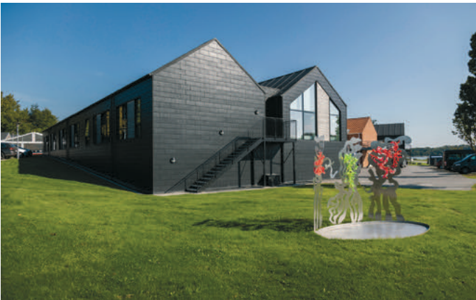
Ein Teil des Anbaus – elf neue Wohneinheiten sind entstanden. FOTOS: KARIN RIGGELSEN
