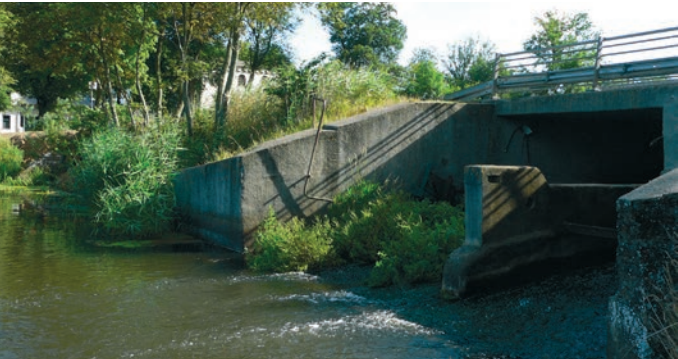
Das Stemmwerk in Jündewatt verhindert die Passage von Fischen.
