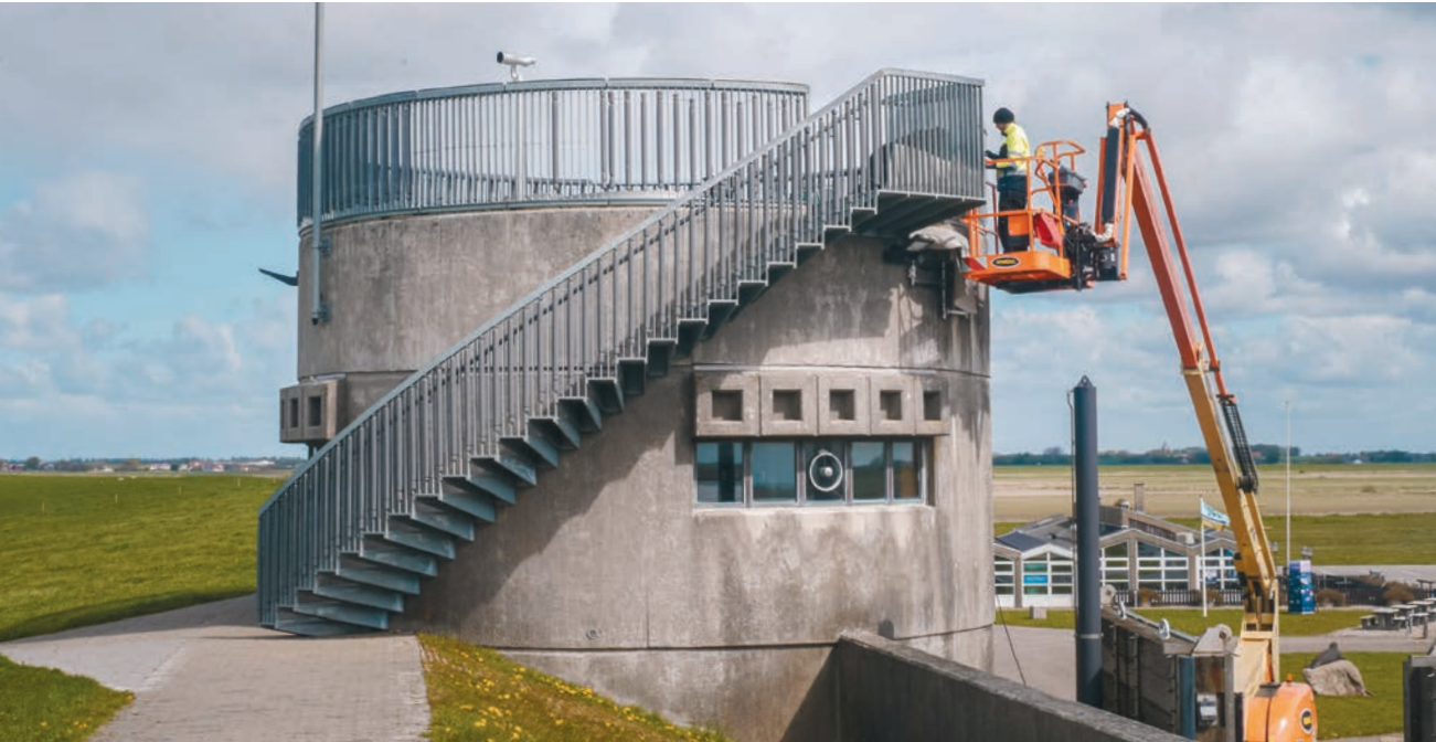
Die Schmiede rücken der Wiedauschleuse aufs Dach.
