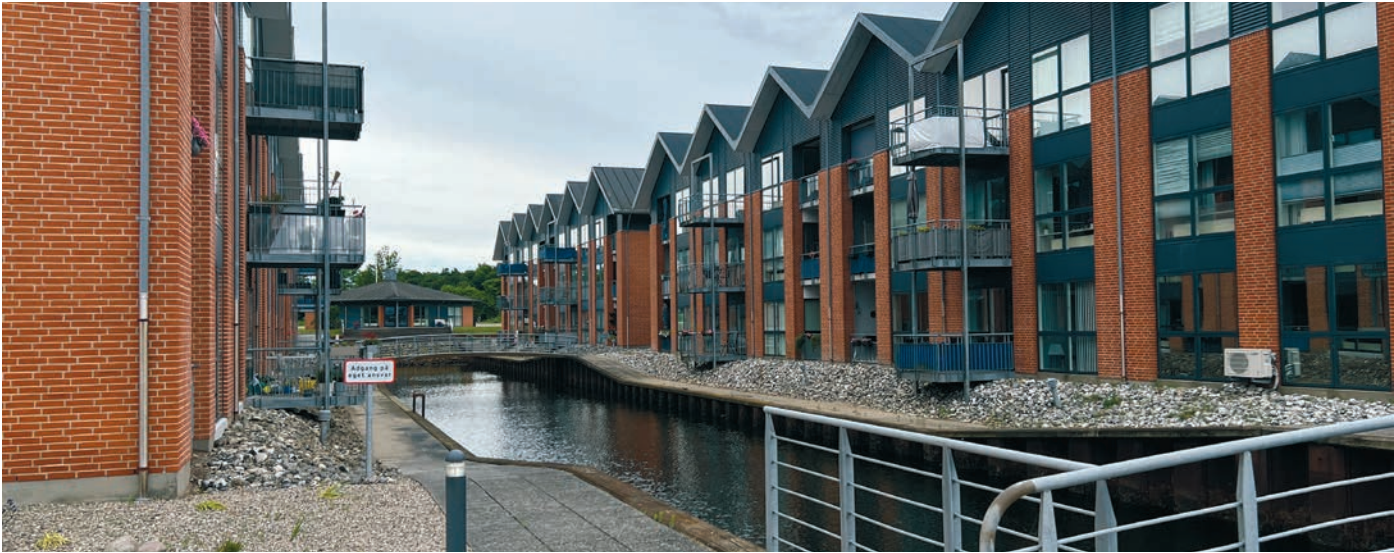
Dieser Kanal am Bryggen lief bei der Sturmflut im Oktober 2023 voll und sorgte für nasse Böden im Erdgeschoss der Wohnung-
