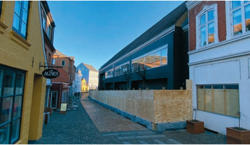
Am früheren Kvikly-Laden endet der Bauzaun. Alle Gebäude hinter dem Zaun werden abgerissen. FOTOS: JAN PETERS
