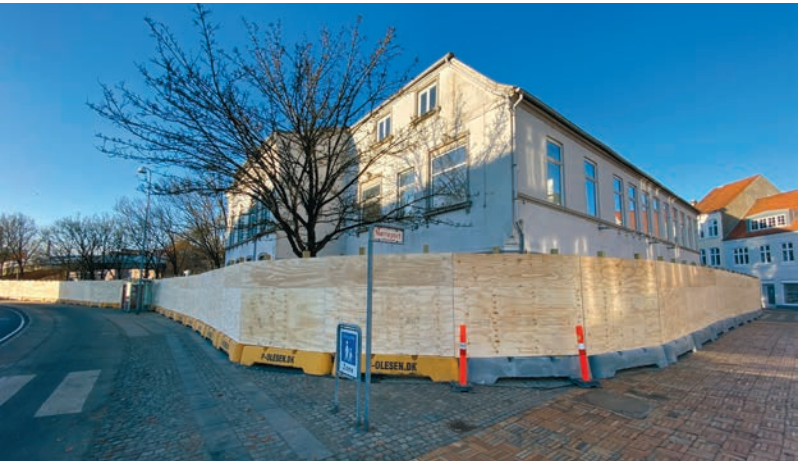
Der Bauzaun macht die Ausmaße des Abrissgeländes deutlich.
