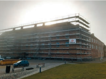
Am Nord-Ostflügel des Schlosses ist bereits ein Gerüst errichtet worden. FOTO: SARA WASMUND
