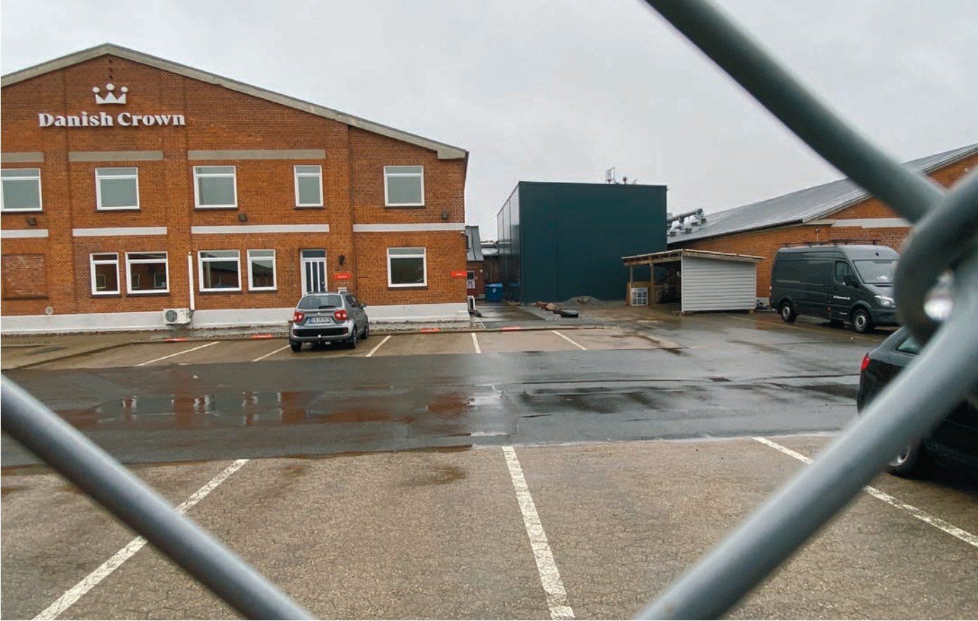
Die Danish Crown Foods-Fabrik am Apenrader Kilen. Im rechten Ausschnitt ist die neue Produktionshalle zu sehen. FOTO: J. PETERS
