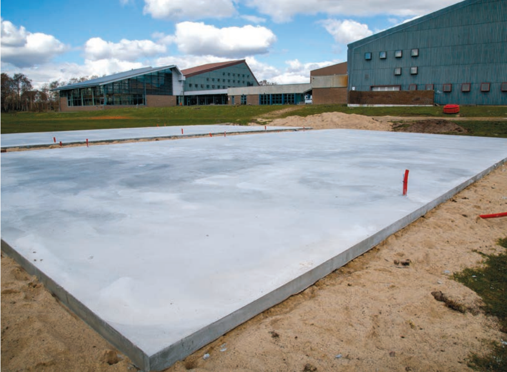
Zwei Paddletennis-Plätze werden ab dem Sommer an der Arena Aabenraa zu bespielen sein. Das Fundament ist inzwischen gegossen.
