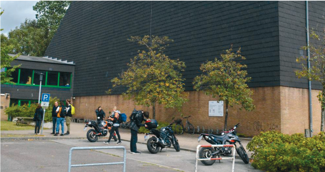
Zurzeit wird die Kreissporthalle am Eisteich noch nicht beheizt. Im Winter soll die Temperatur soweit wie möglich heruntergeregelt werden.
