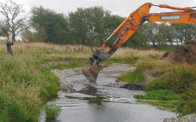
Mit dem Bagger wurde ein kleiner Kiesdamm geöffnet, damit der Sauerbek wieder ganz natürlich vor sich hinplätschern kann. VOLKER HEESCH
