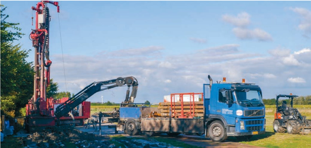
Das Unternehmen Poul Christiansen hat in Hoyer mit modernem Gerät nach neuen Trinkwasservorkommen im Bereich östlich des Ballumvej gebohrt. Es wurde kein nutzbares Wasser aufgespürt. Es folgen neue Versuche. VOLKER HEESCH
