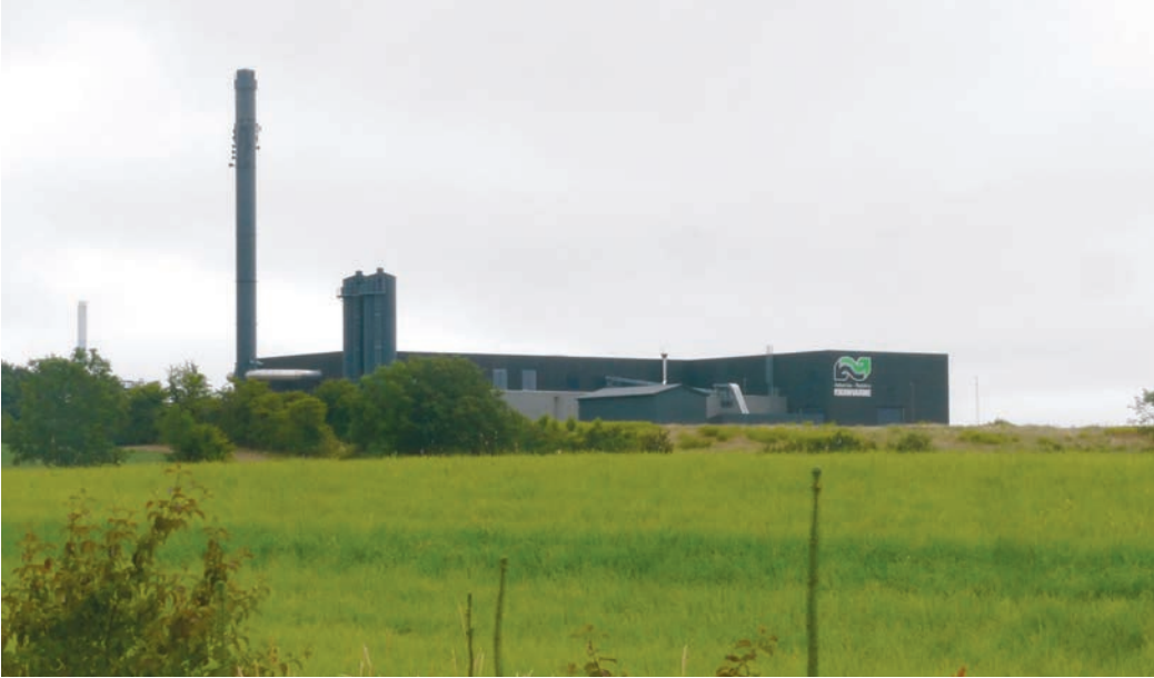
In Apenrade setzt die örtliche Fernwärmegeellschaft schon seit Jahren auf „grüne“ Energie. Nach dem Ende der Nutzung von Restwärme des Steinkohlenkraftwerks Enstedtwerk steht klimaneutrale Biomasse als Energieträger im Mittelpunkt.
